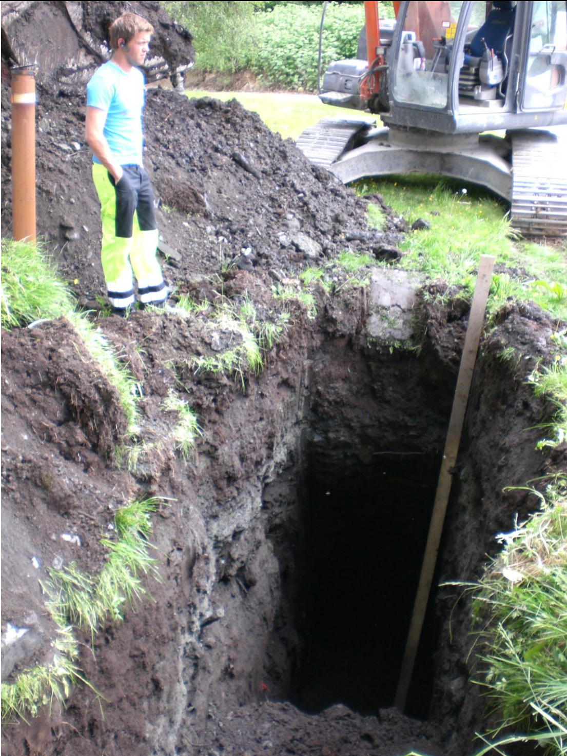
Foto 7-1. Sjakt 7. Blandet naturlig jord til ca 2.5 m under terreng. Derfra avfall til ca 5 meter. Relativt tørt avfall. Sjaktveggene er stabile, og massene er gravbare.
