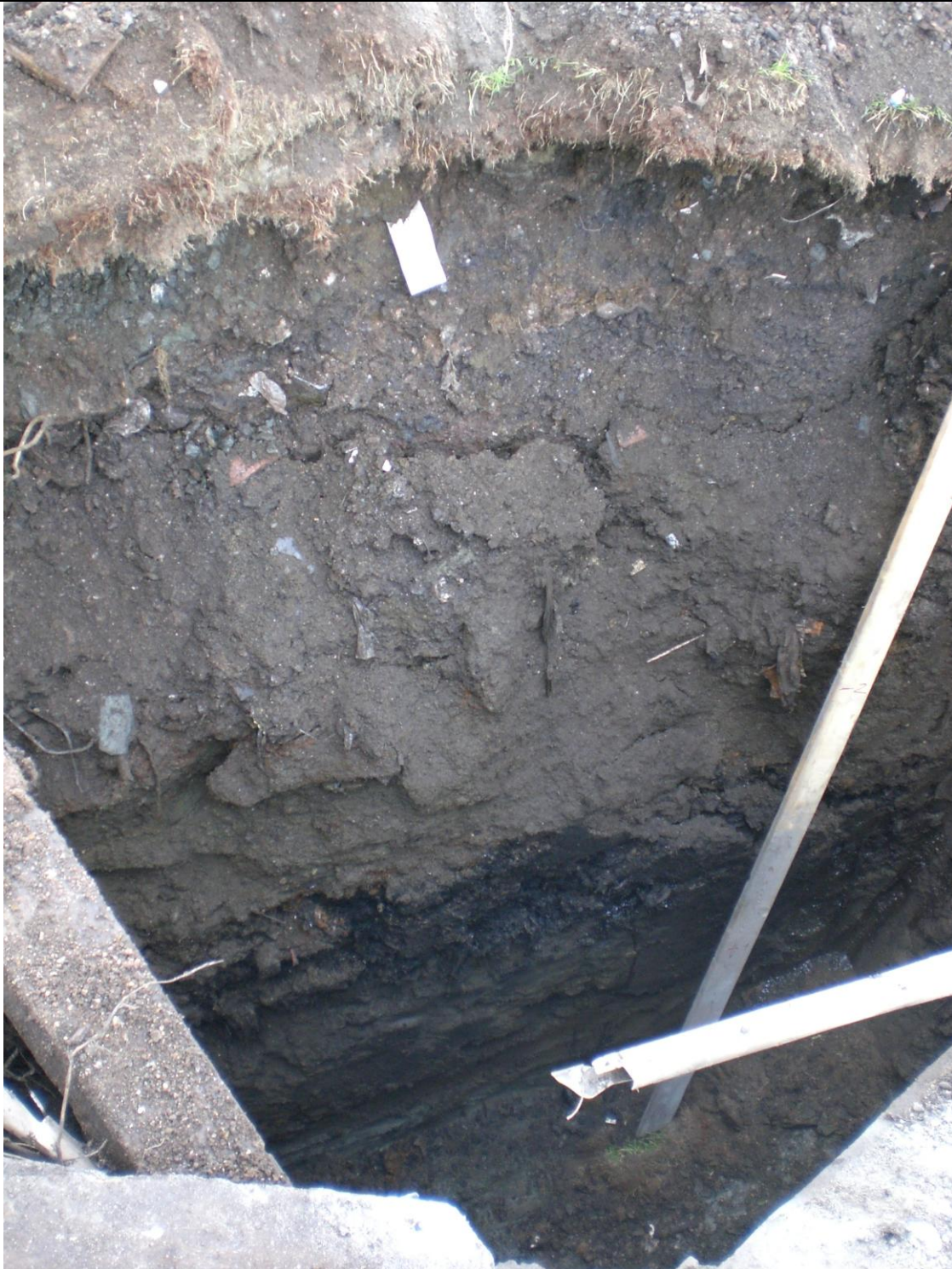
Foto 8-1. Sjakt 8. Lett fuktig avfall ned til leire over fjell på ca 3,5 m under terreng. Ikke innsig av vann. Sjaktveggene er stabile, og massene er gravbare.
