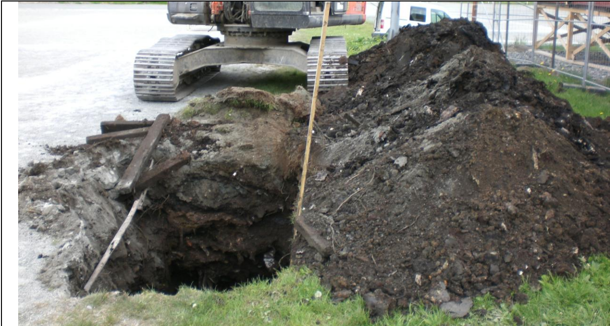
Foto 8-2. Sjakt 8. Oppgravde avfallsmasser er tørre og lett å handtere.
