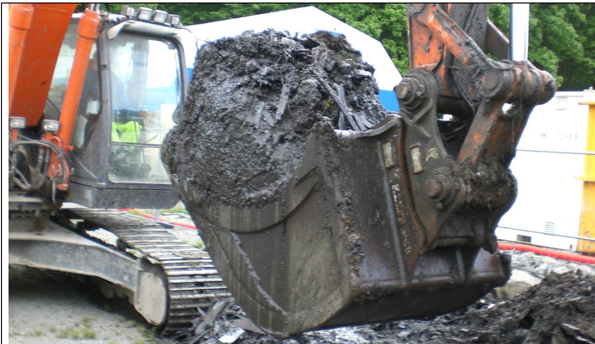
Foto 2-2. Sjakt 2. Oppgravde avfallsmasser har en viss struktur, og flyter lite utover. De er altså mulig å transportere.
