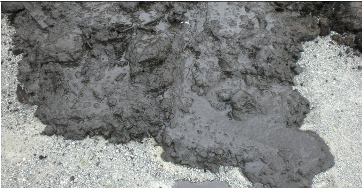
Foto 6-4. Sjakt 6. Våte masser ned mot fjell er mer utflytende.
