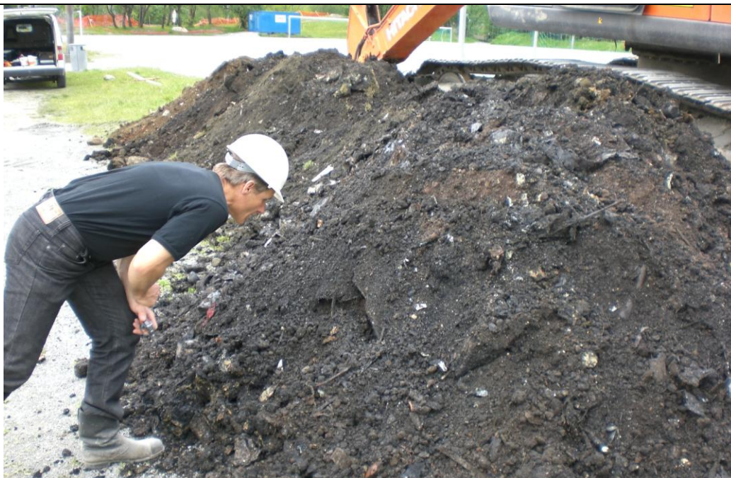
Foto 6-2. Sjakt 6. Oppgravde avfallsmasser er nokså tørre.
