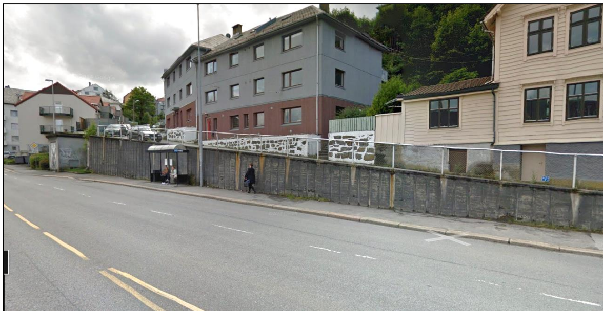
Figur 41 Laksevåg retning Gyldenpris. Lav kantstein. Ingen leding. (Kilde: Google Maps)
