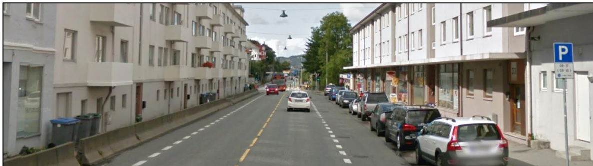
Figur 48 Langsgående parkering uten markert buffer mot bilrekken. (Kilde: Google Maps)
