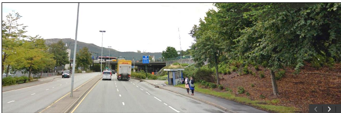
Figur 35 Gyldenpris retning sentrum. Lav kantstein, ingen taktil leding. (Kilde: Google Maps)
