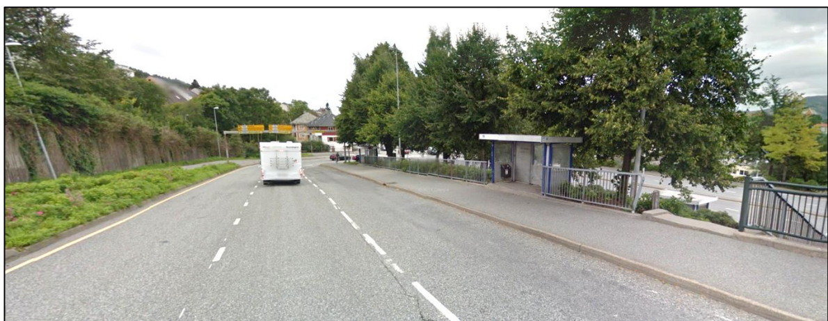
Figur 36 Gyldenpris mot Carl Konows gate. Lav kantstein, ingen taktil leding. (Kilde: Google Maps)
