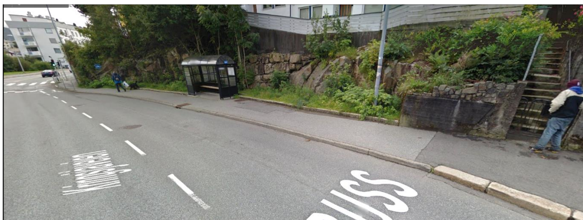
Figur 45 Hølen retning Gyldenpris. Lav kantstein. Ingen leding. (Kilde: Google Maps)
