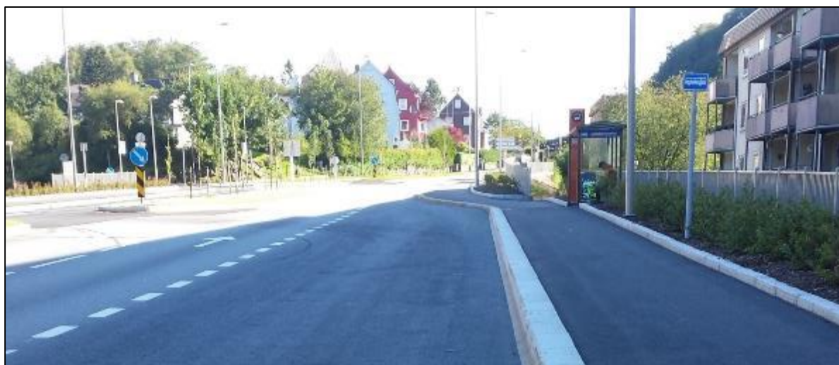
Figur 34 Oppgradert holdeplass i Lyderhornsvegen retning sentrum
