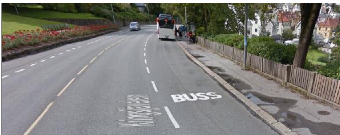
Figur 40 Damsgård hovedgård retning Gravdal. Veldig lav kantstein, smalt fortau. Ingen leding. (Kilde: Google Maps)
