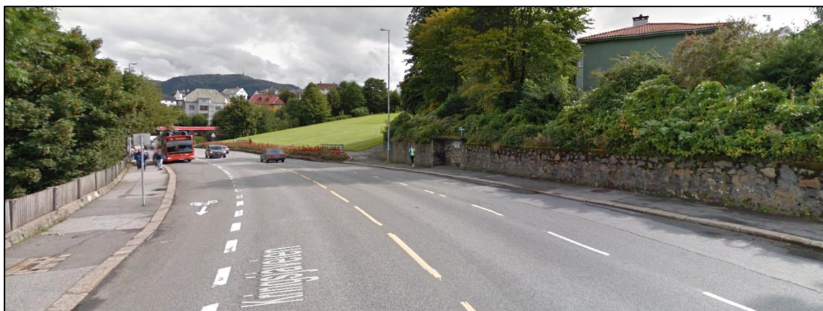
Figur 39 Damsgård hovedgård retning Gyldenpris. Veldig lav kantstein, smalt fortau. Ingen leding. (Kilde: Google Maps)
