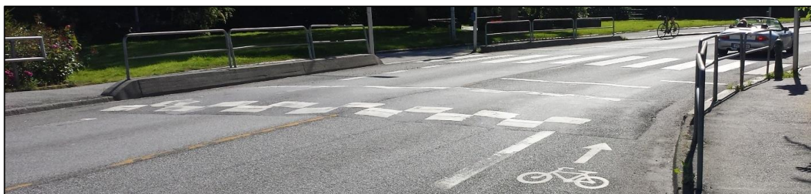
Figur 51 Fartshump som er avsluttet midt i sykkelfeltet
