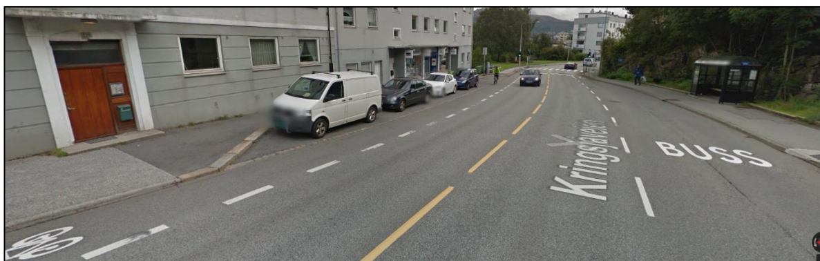
Figur 49 Sykkelfelt uten buffer mot bilrekken. (Kilde: Google Maps)
