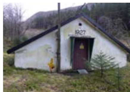
Utrangert pumpestasjon ved Kobbeltveit i Våkendalen.
