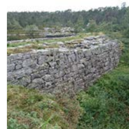
Dobbel murdam med torv- eller jordtetting i Nordre ende av Storevatnet i Munkebotn vassdraget.
