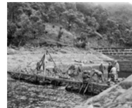
Tre generasjoner dammer; den fremste fra mølle drift, den andre fra 1854 bygget i for byens første vannverk, den tredje fra 1881. I dag ligger alle disse under vann i og med at byggingen av Svartediksdammen i 1953 hevet vannspeilet med 11 meter. Svartediksdammen er et statlig listeført teknisk kulturminne. (Foto: Marcus UiB/ubb-bs-ok-13209.)
