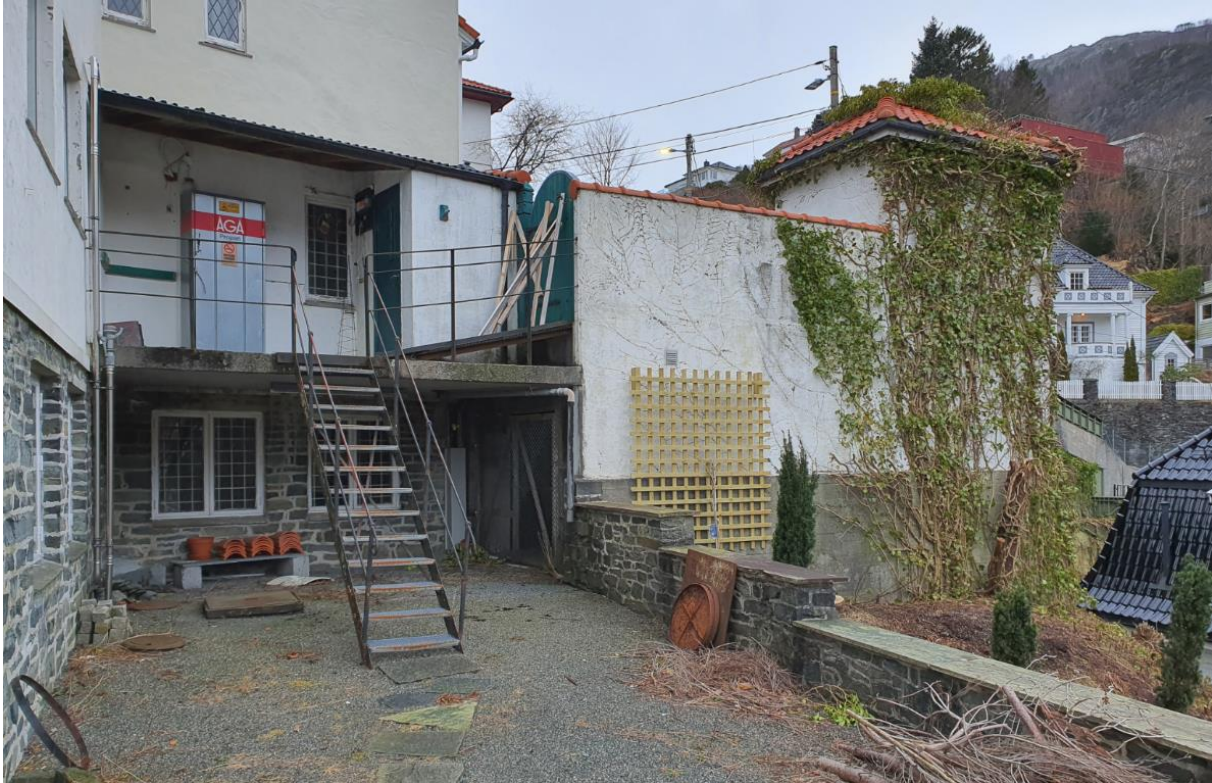
Figur 34 Bilde som viser trapper og betongvegg/mur nordøst i planområdet som skal rives.
