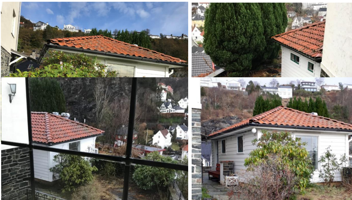
Figur 33 Bilder av uthus øst i planområdet som skal rives slik at området kan tilrettelegges for felles uteoppholdsareal.
