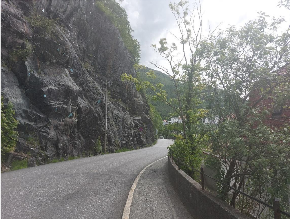
Figur 22: Sørlike del av strekningen med boltesikring og sikringsnett.
