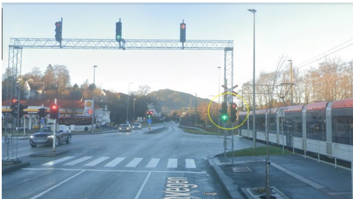
Figur 19. Årsaken til hendelsene med konflikt mellom Bybanen og biltrafikk til/fra Sandalsvegen er at noen biler kjører på rødt lys. Grønt lys rett frem rett ved høyresvingefeltet fra sør kan være en faktor som er med å påvirke trafikantene og forårsake kjøring på rødt lys til høyre. Foto: Google.
