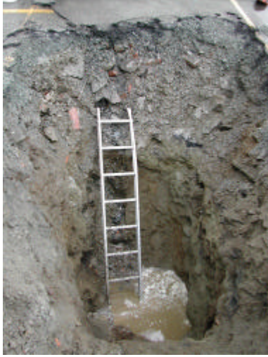
Figur 9.7 Bilde fra øvre del av jordmassene i prøvepunkt nr 2.
