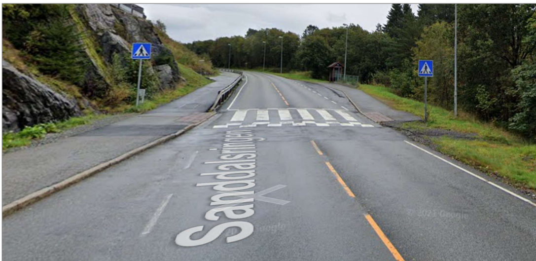
Figur 17 Bilde fra fv 5198 Sanddalsringen, som viser fortau i sørgående kjøreretning, med fotgjengerovergang til et kortere strekke med fortau i nordgående kjøreretning opp til bussholdeplassen Kjenndalslia tett på planområdet.
