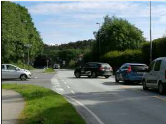
Figur 12. Krysset Sandslivegen / Saksarhaugen er vikepliktsregulert fra Saksarhaugen og det er ikke egne svingefelt for trafikk fra Sandslivegen til Saksarhaugen.
