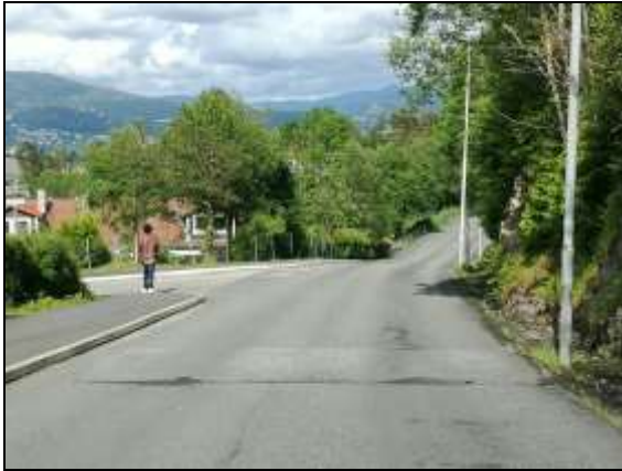
Figur 6. I dag er det 30 km/t, fartshumper og sammenhengende fortau langs Saksarhaugen.
