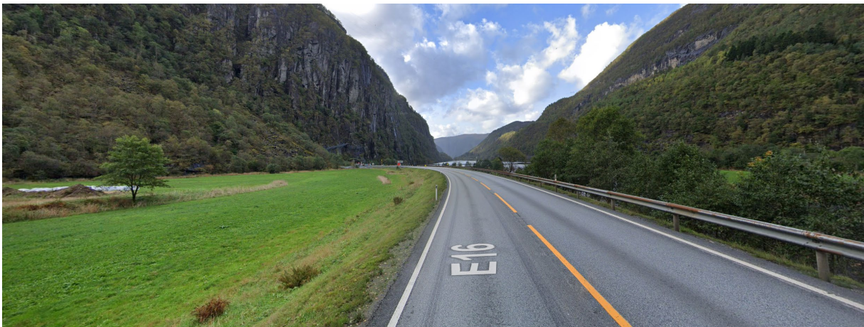
Figur 9-2 Dalehagen, dagens situasjon sett i retning mot Dalevågtunnelen
