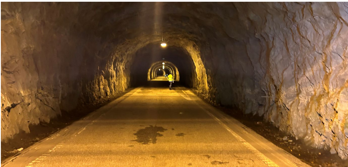
Figur 11-24 Parti fra Raudberg tunnelen. Eksisterende oppmerking er fra perioden før 1994 da tunnelen var en del av hovedvegen. To sett med kantlinjer viser at det da ble praktisert sentrisk kjøring for store kjøretøy. Om lag midt i tunnelen er det en utvidelse som gir mulighet for store kjøretøy å møtes. Deler av tunnelen har problemer med innlekkasje og issvuller om vinteren (kilde Bergen kommune).
