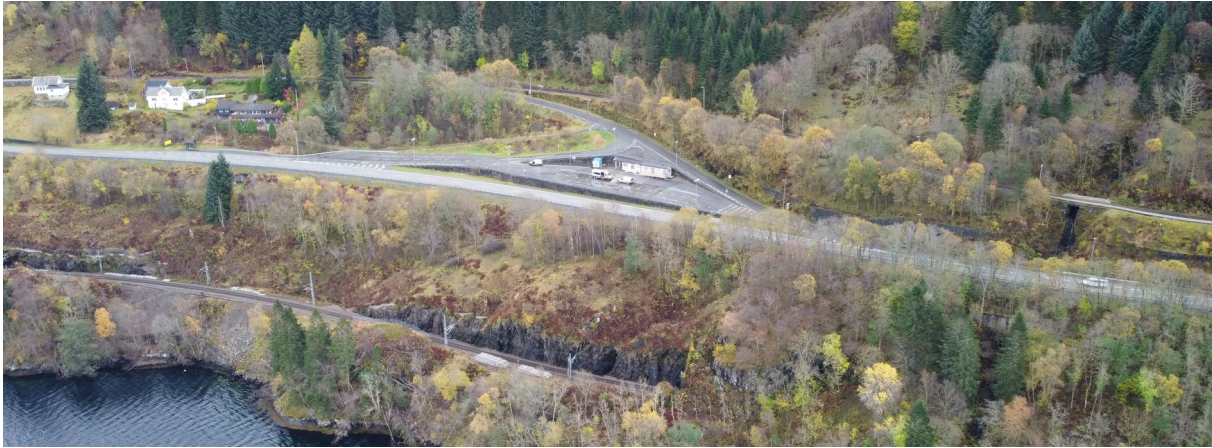
Figur 4-2 Dagens vekt- og kontrollplass blir riggområde og påhugg for anleggstverrslag. Som tilkomst til E16 etableres rundkjøring «Romslo vest».
