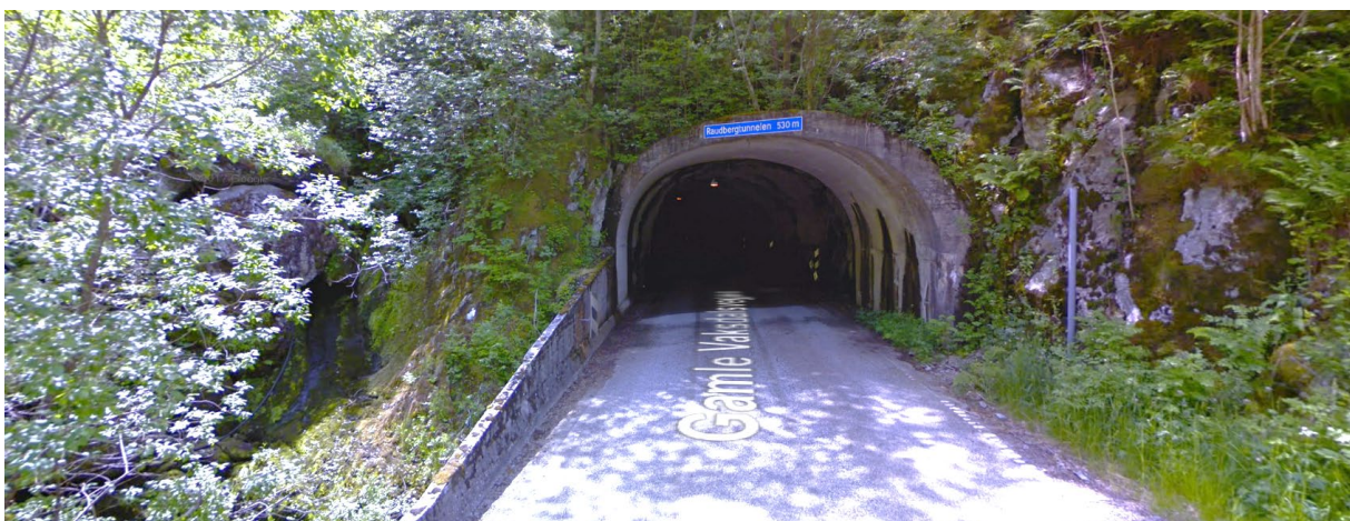
Figur 11-22 Raudberg tunnelen, nordre munning. (kilde Google Maps)
