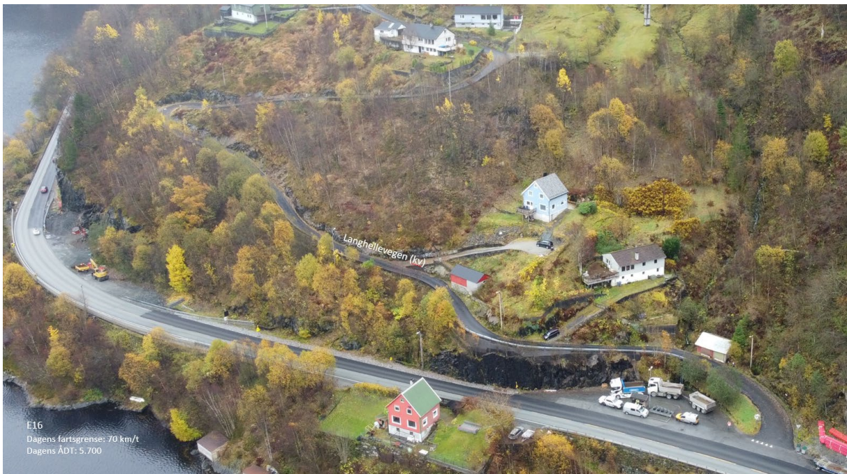
Figur 7-1 Dagens situasjon ved Langhelleneset
