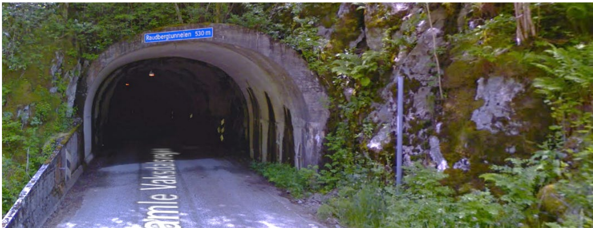
Figur 11-11-27 Raudberg tunnelen har høydebegrensning 4,0 meter. Som del av tiltak i tunnelen må skilt på plass. Det gjelder også forvarsling på E16 ved Rødberg.
