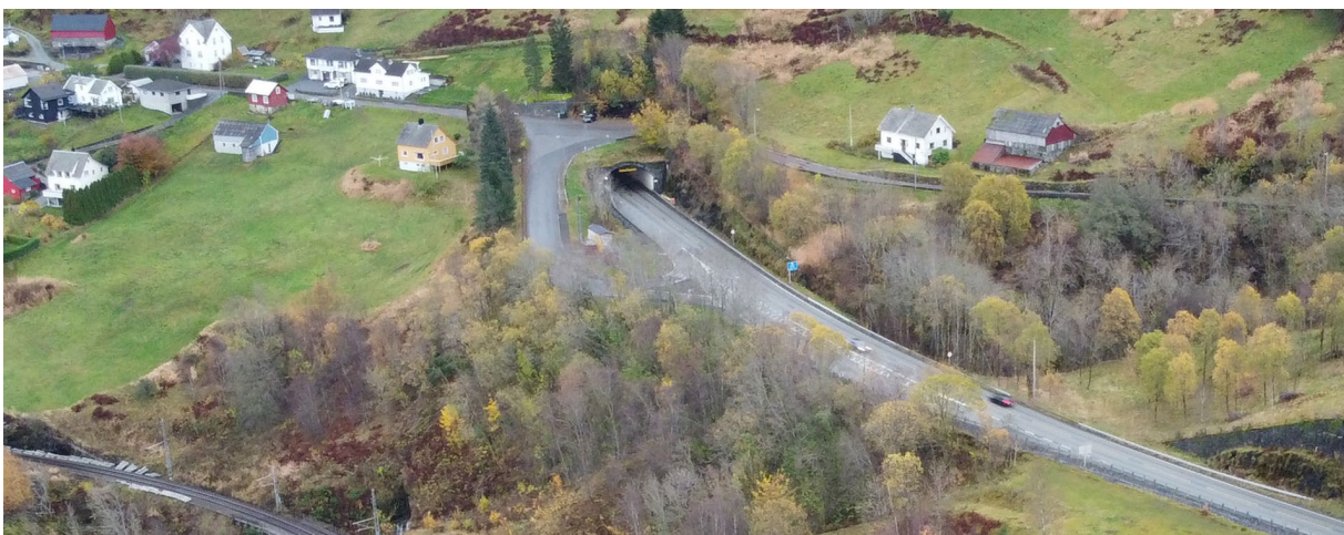
Figur 4-3 Dagens situasjon der midlertidig rundkjøring «Romslo øst» vil gi ny tovegs tilkomst til/fra Romslovegen
