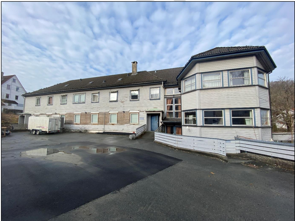
Figur 1 Eksisterende bygg på Øvre Fyllingsveien 48, østfasade. Foto fra befaring av 3RW 2021.
