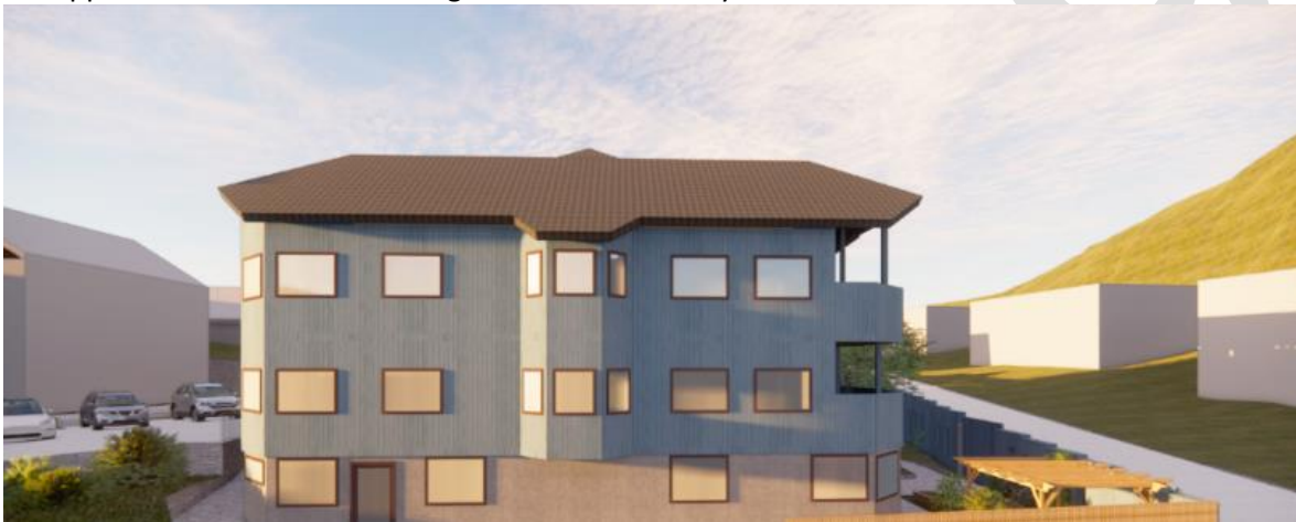
Figur 48 Fasaden mot vest (t.h.) er trukket inn. Dette gir et privat uterom, hvor tett rekkverk sørger for dempet fasade bakom, Lden=57 dB.
