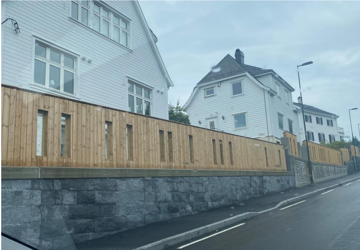
Figur 52 Foto fra befaring, støyskjerm i Øvre Fyllingsveien.
