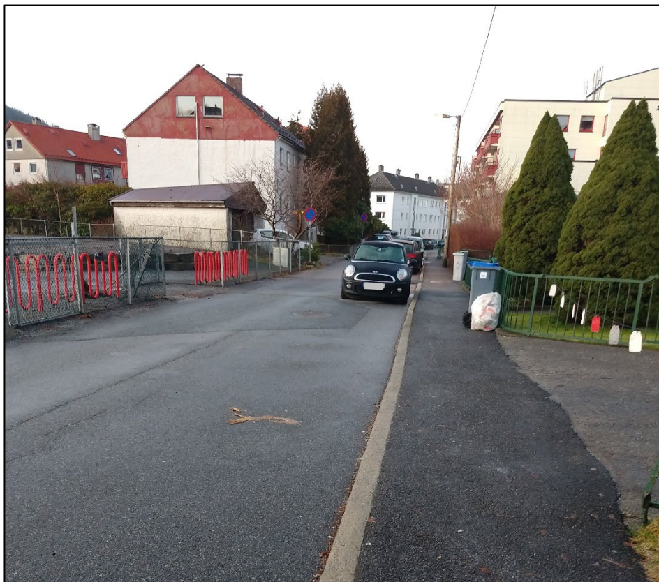
Figur 5 - Bendixens vei. Vegstrekning like foran planområdet, som ligger rett til høyre i bildet.
