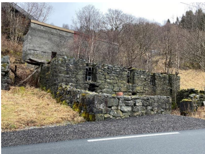
Figur 11: Gammelt steinfjøs kan bygges om og benyttes til ventilhus og trykkforsterker.
