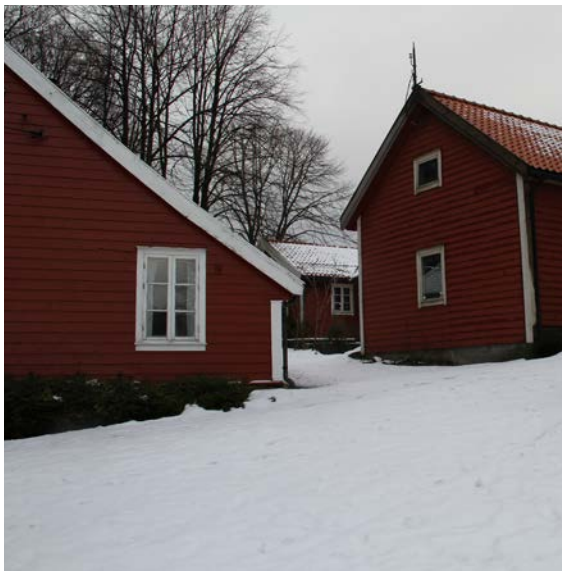
Grendahus, stall og mannskapsstasjon i bakkant
