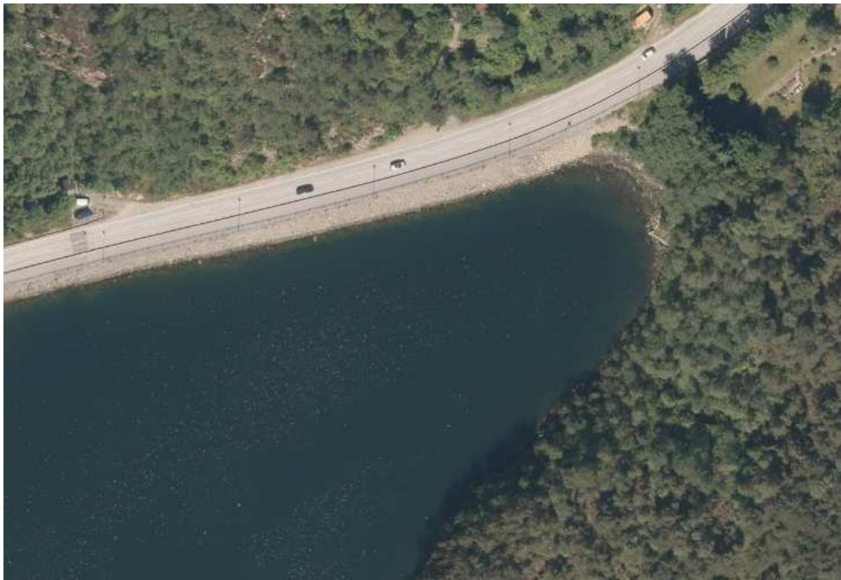
Flybilde over Tømmervika. 558 Håkonsvernveien går i fylling langs nordre delen av bukta.
