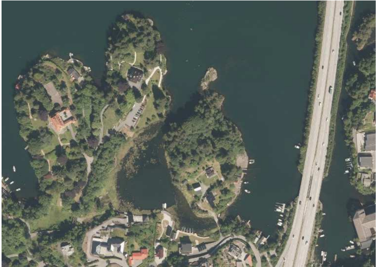
Flybilde over Hopsbukta. E39 til høyre.
